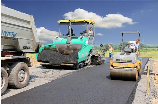
Herstellung einer bituminöser Tragschicht mittels Fertiger und Glattmantelwalze\*
